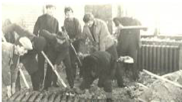
Преподаватели и сотрудники на уборке строительного мусора
